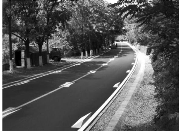
En varios distritos de China, en una variedad de diferentes tipos de carreteras, se pusieron a prueba señales viales específicamente diseñadas que crean una ilusión estereoscópica
