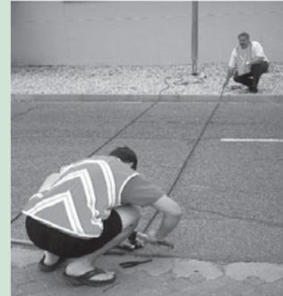
Los detectores de lazo son cables cortados y colocados en la superficie del asfalto de la carretera, recubiertos y conectados al registrador de datos emplazado en una cabina al borde de la carretera. Puesto que los cables de medición están ocultos, no se deterioran con el flujo del tránsito. Dependiendo de los flujos y de la capacidad de almacenamiento del aparato de registro, el equipo se puede dejar desatendido durante semanas.
